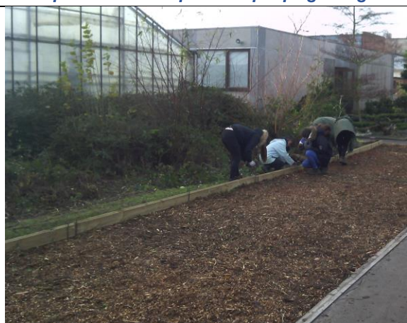
Pose et mise à niveau des planches de bordure
