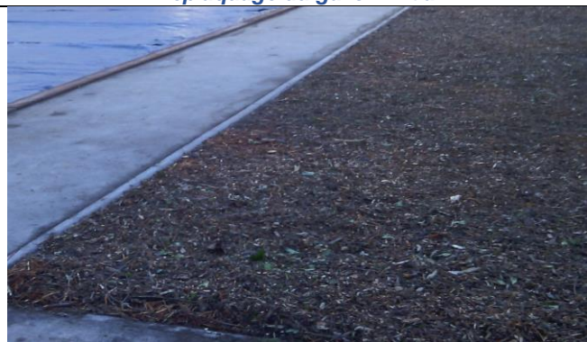
Mise en place d'une sous bâche et du Bois raméal fragmenté
